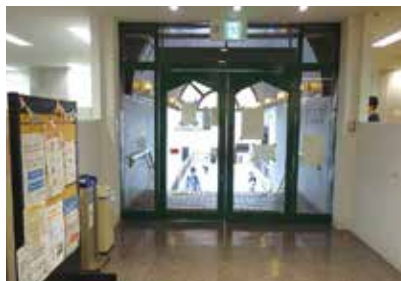
アドバンスねやがわ2号館と3号館との連絡通路には階段があり、安全な往来には工夫が必要だ。
