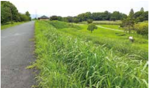
深北緑地の仕切堤から右手にAゾーンを見下ろす
