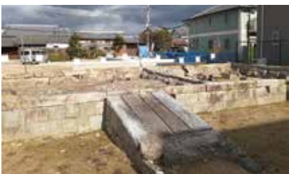
平野屋新田会所跡(米蔵の基礎部分?)
